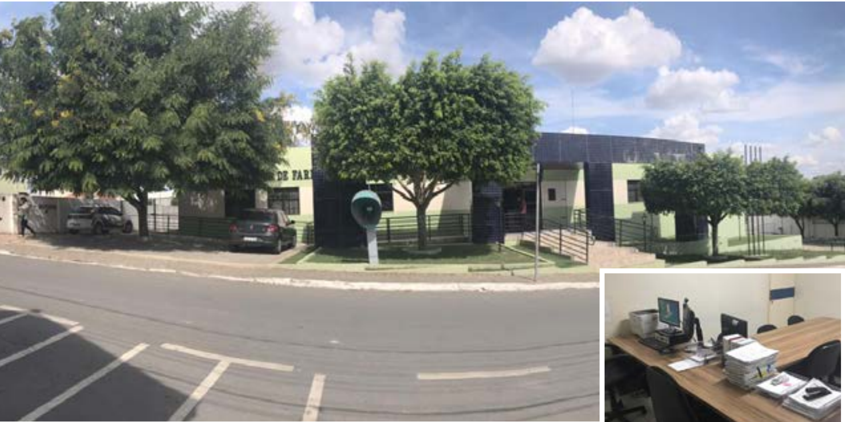
O Fórum da Comarca de Queimadas passou por reformas e recebeu ambiente para abrigar o Cejusc.
